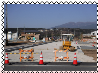
道路新設工事の状況
