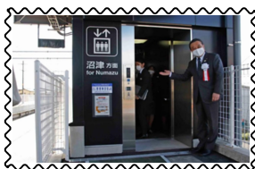
岩波駅エレベータ入口周辺の状況
